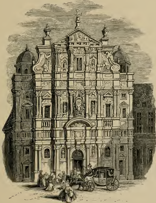
Fig. 10.—Church of S. Carlo Borromeo.
